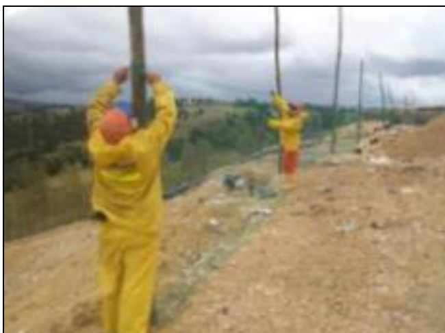
Figura 12. Instalación de mallas antivuelos en la zona donde se disponen los residuos sólidos
