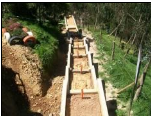
Figura 21. Tratamiento Biológico Aeróbico
