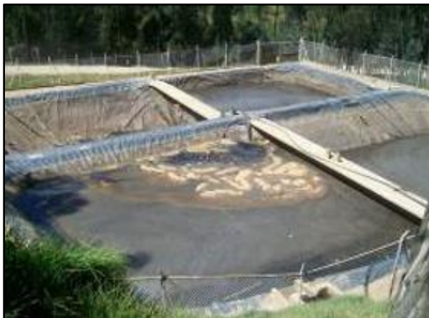
Figura 22. Lagunas Anaerobias Fuente: ServiTunja S.A E.S.P
