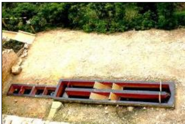
Figura 15. Sistema de rejillas y rejillas Fuente: ServiTunja S.A E.S.P
