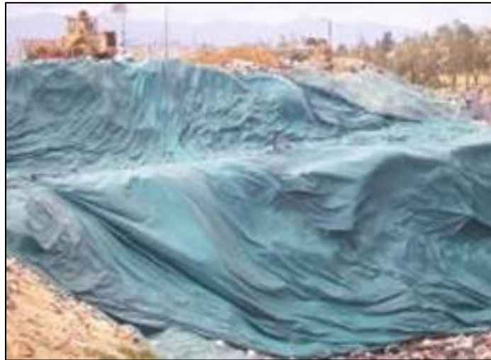
Figura 10. Cobertura temporal con geosintético
